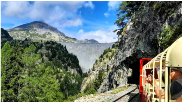
Letzter Tunnel vor der Staumauer
