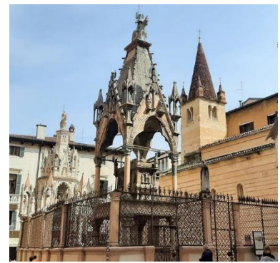
Arche Scaligere und Santa Maria
